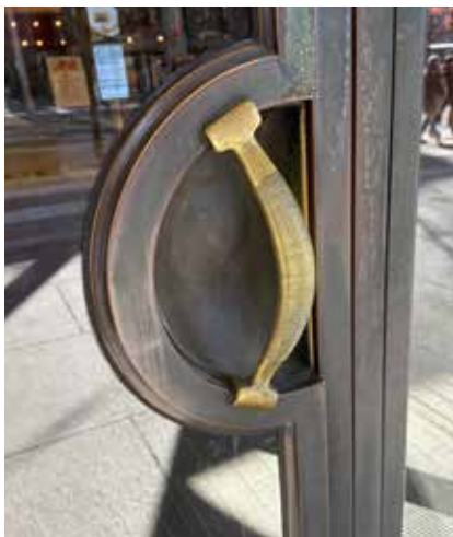
Rekonstruktion och gjutning av äldre handtag. (NK i Stockholm)
