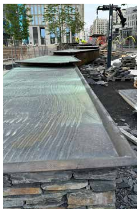
Här monteras en 40 meter vattenspegel gjuten i åtta sektioner i brons. Hagastaden i Stockholm, 2023.
