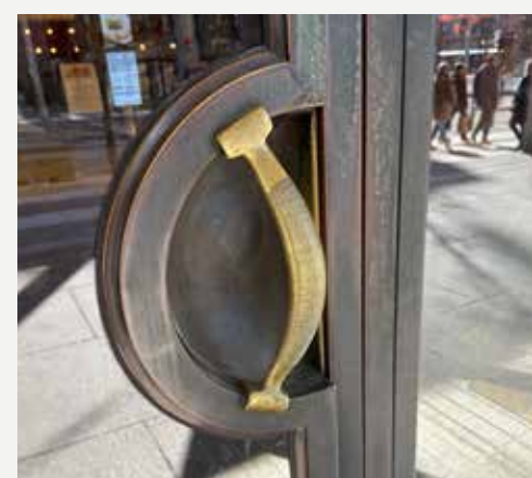
Rekonstruktion och gjutning av äldre handtag. (NK i Stockholm)
